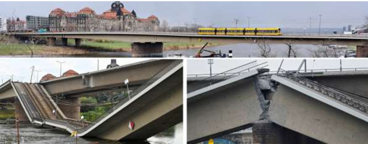
Most Carolabrücke w Dreźnie 1971-2024 (po 53 latach) schemat statycznie wyznaczalny z przegubami Gerbera
