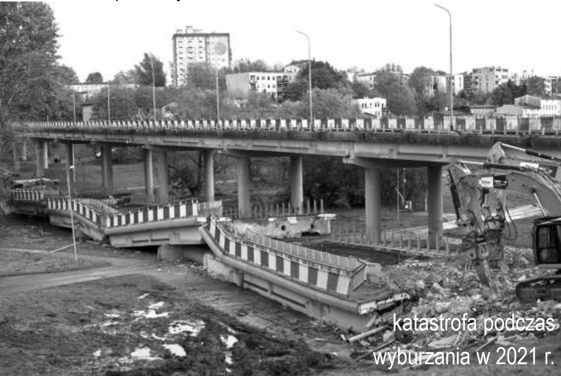
prefabrykowana estakada w Koszalinie
