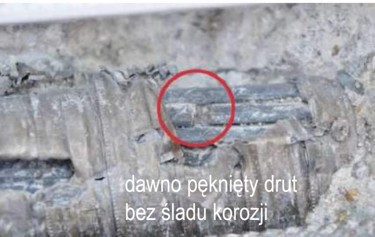
odkrywka osłonki z kablem w betonie
