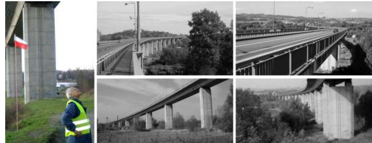
Most graniczny w Cieszynie 1990-.... (35 lat użytkowania) schemat statycznie niewyznaczalny z belką ciągłą
