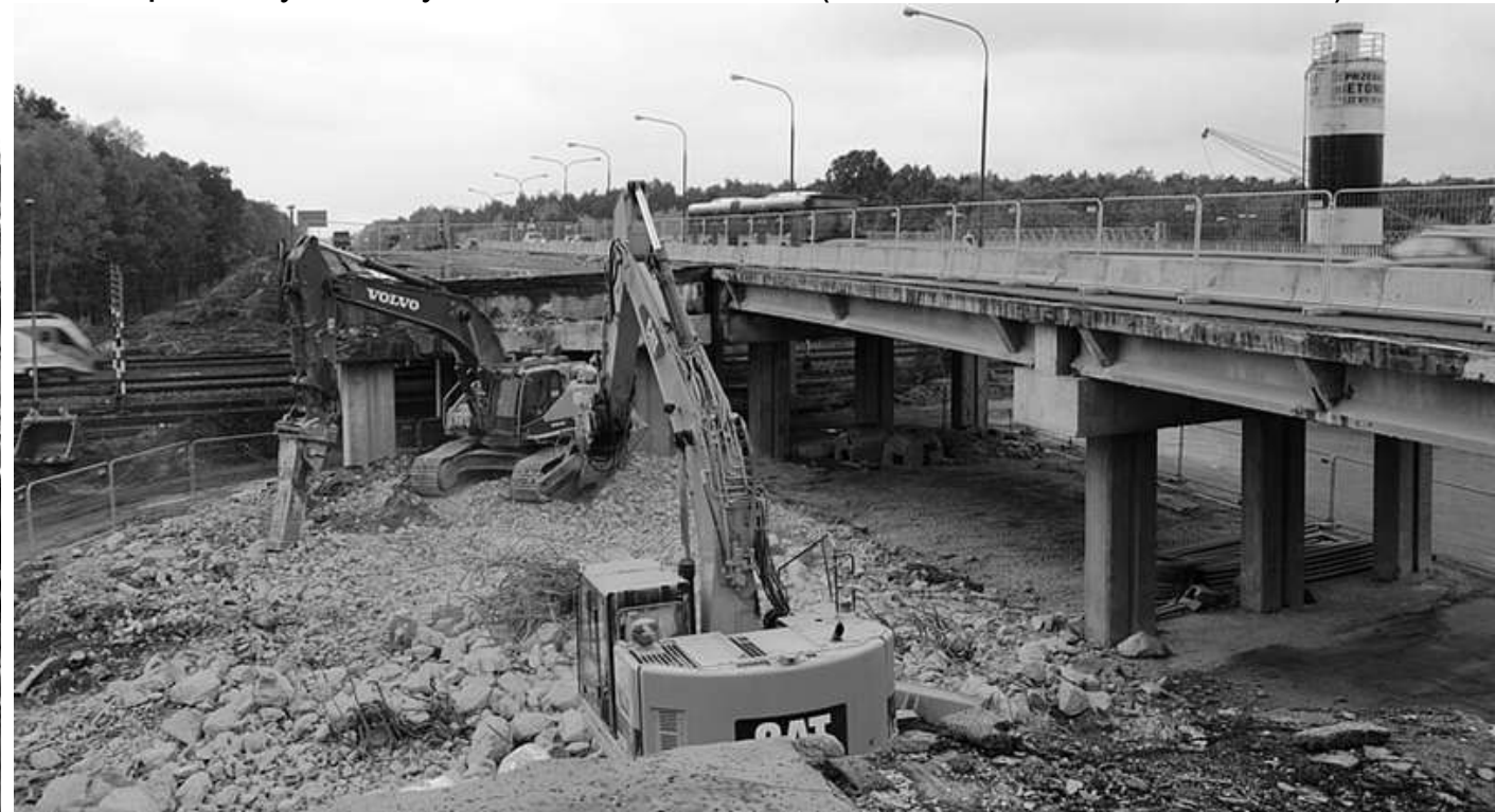
prefabrykowany wiadukt nad torami (ul. Żołnierska w Warszawie)
