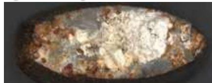
odkrywka osłonki z kablem w betonie
